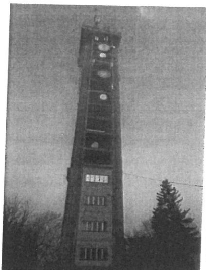
Widok obiektu wraz z zainstalowanym zespołem antenowym
